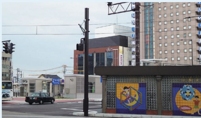
信号機付電車線柱
