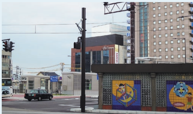
信号機付電車線柱
