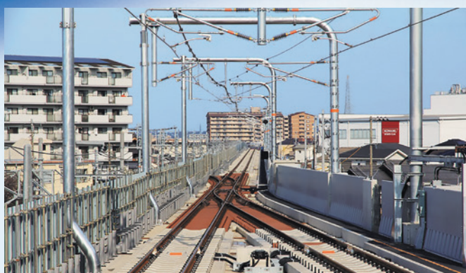
鋼管柱・鋼管ビーム
