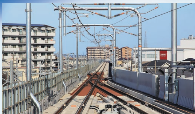
鋼管柱・鋼管ビーム
