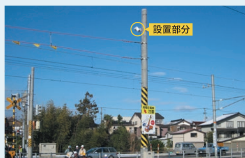
踏切設置(全景)
