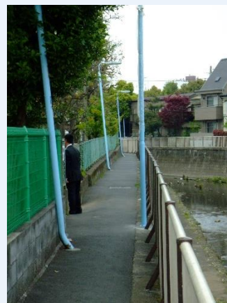
③ジョイント完了最終形
