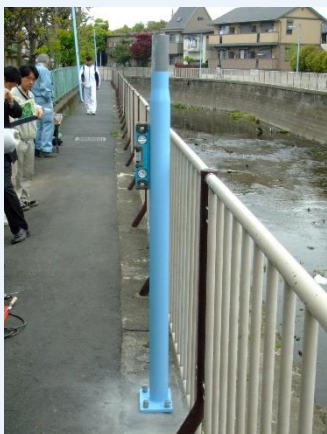
①分割タイプ下柱を設置
